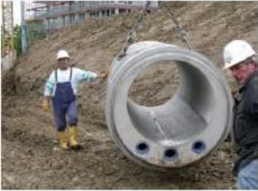
Рис.6 - Каналізаційний елемент із вбудованим теплообмінником [1]
